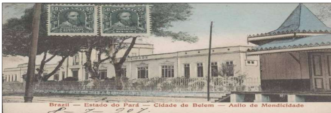
Figura 48 – Asilo da Mendicidade
