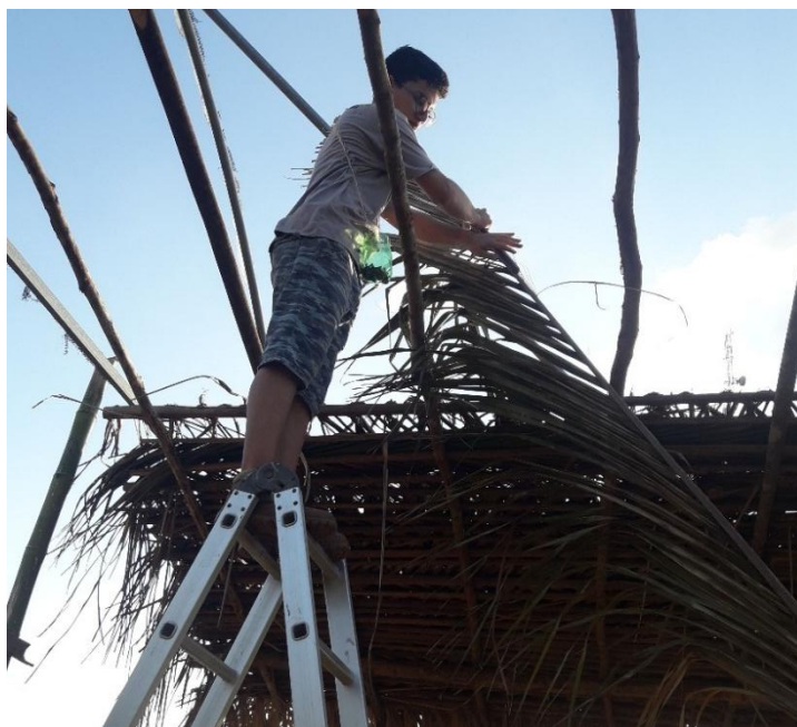
Imagem 23: Teto já quase finalizado.
